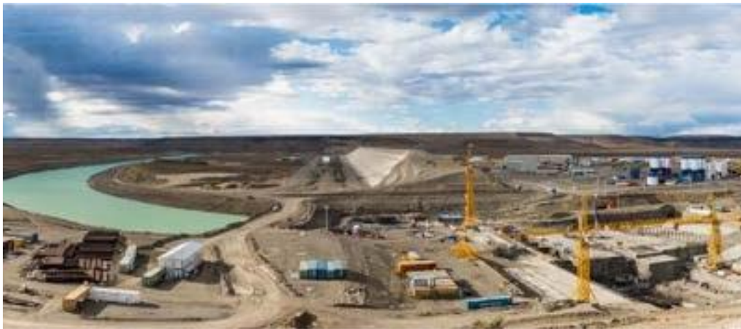
Aprovechamiento Hidroeléctrico del Río Santa Cruz – Santa Cruz – Argentina
